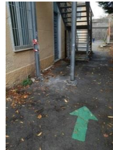
Basamento scala antincendio
